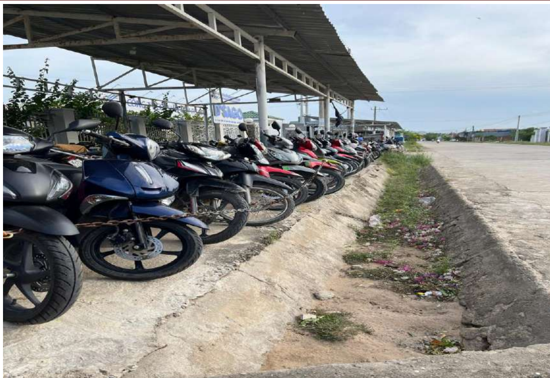
Hình 3-2: Điểm thoát nước mưa .
