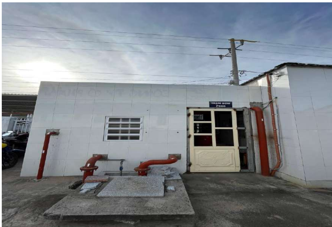
Hình 3-9: Nhà bơm phòng cháy chữa cháy
